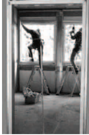
» Kapı Ankrajının kullanılması (Kişisel düşmeyi durdurucu sistem)
